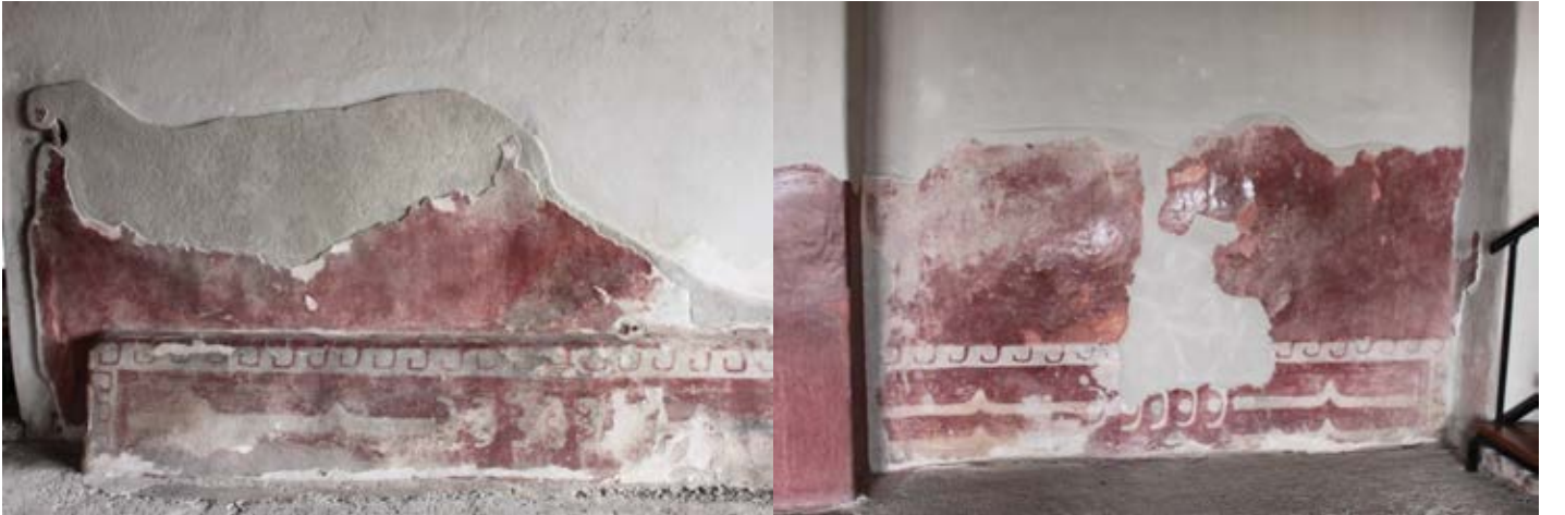
Las paredes del Palacio de los Jaguares / Walls in Palacio de los Jaguares
